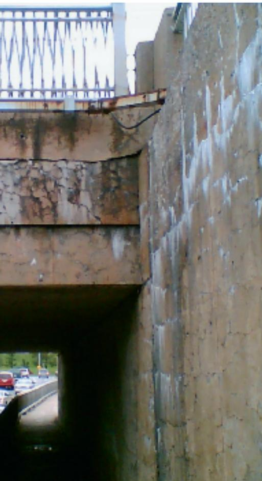
erreicht. In einem solchen Bauteil kann die Temperatur während der ersten drei Tage über 40 °C liegen und Maximalwerte von über 60 °C erreichen. Zudem ist der Feuchtigkeitsgehalt wegen der langsamen Austrocknung generell hoch. Diese Faktoren begünstigen die Beschleunigung der AAR und der damit verbundenen kritischen Expansion, die bereits in einem jüngeren Alter des Bauwerks Schäden verursacht.
